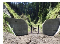
流木捕捉式治山ダム
